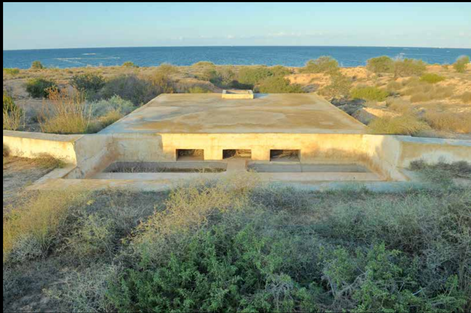
Petit ouvrage hydraulique abandonné dans l'archipel kerkenien
