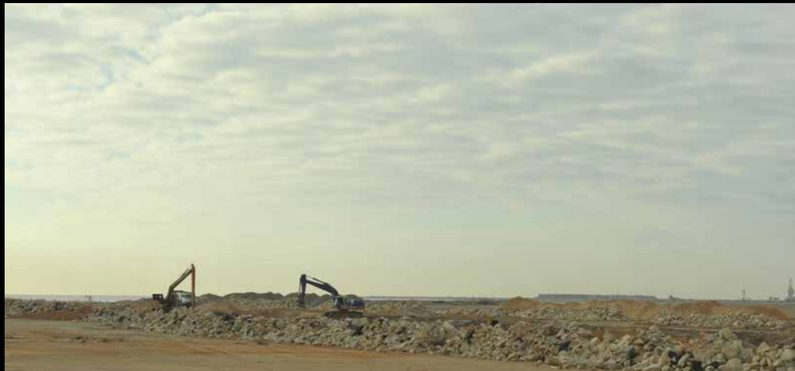
Et des aménagements en cours de réalisation sur des terrains gagnés sur la mer et très bas (le projet Taparura à Sfax)
