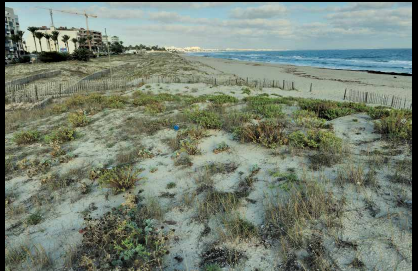
Par la reconstitution des dunes de haut de plage par la méthode des ganivelles (Mahdia)
