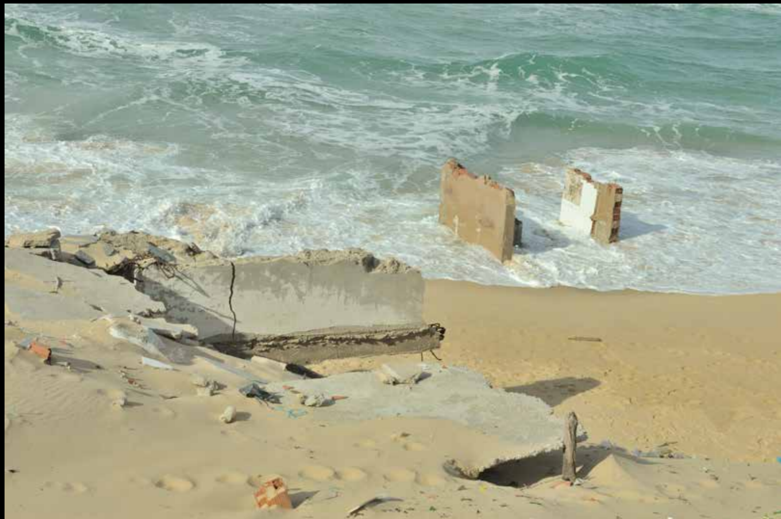
Les vagues toujours à l'œuvre : constructions récentes annexées à la mer (plage de Zouara)
